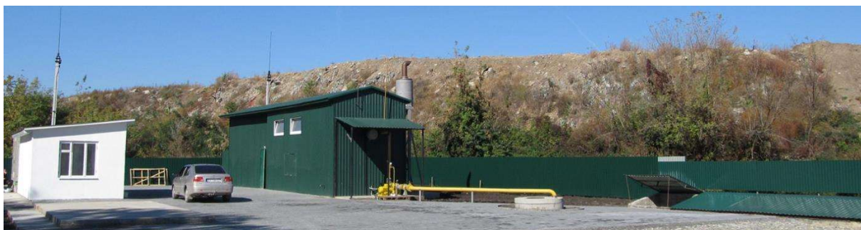
Біогазова електростанція м. Кам'янець-Подільський
