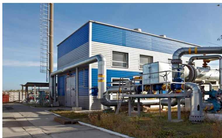
Рисунок 14 – Детандер-генератор УТДУ-4000-4,5-4,5-УХЛ4 потужністю 4 МВт
