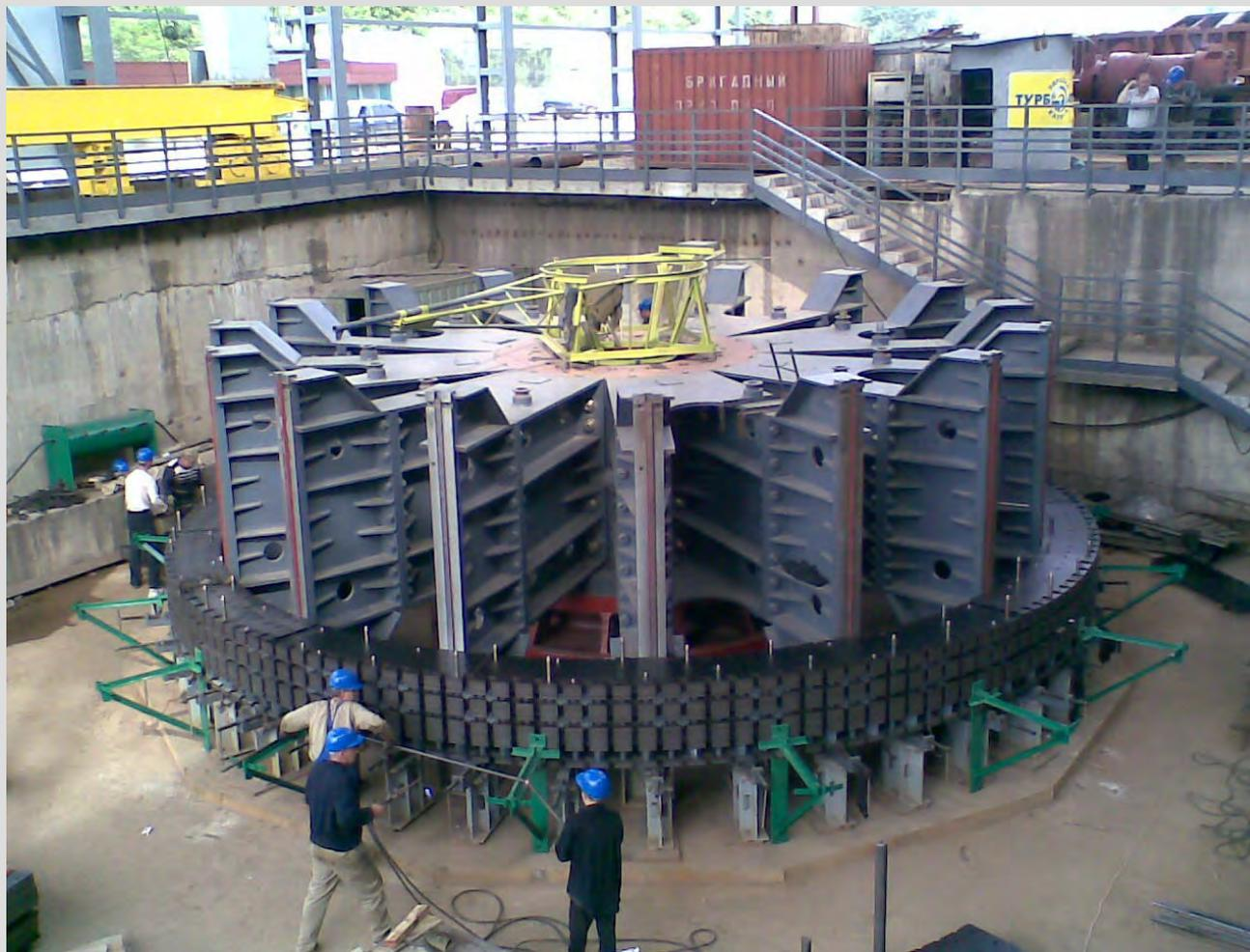
Збірка ротора двигуна-генератора на монтажному майданчику
