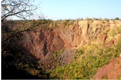
Рис. 1 Провальні зони земної поверхні (шахта «Тернівська» ПАТ КЗРК, шахта ім. Орджонікідзе ПрАТ ЦГЗК, 2010р.)
